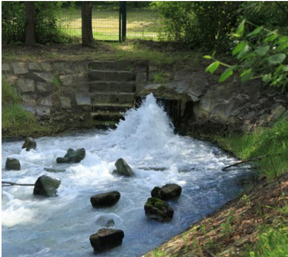
Grubenwassereinleitung Harpener Teiche, Bochum
